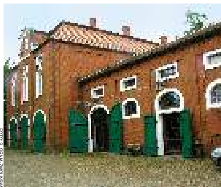
Stajnie w Pępowie
