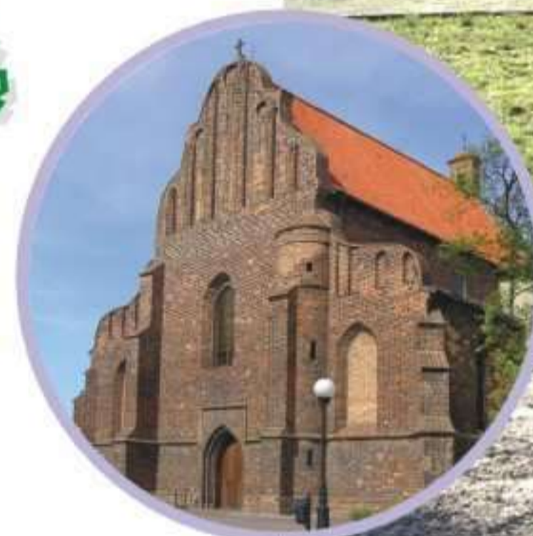
Kościół pw. św. Bernarda, Fot. Z. Szmidt
