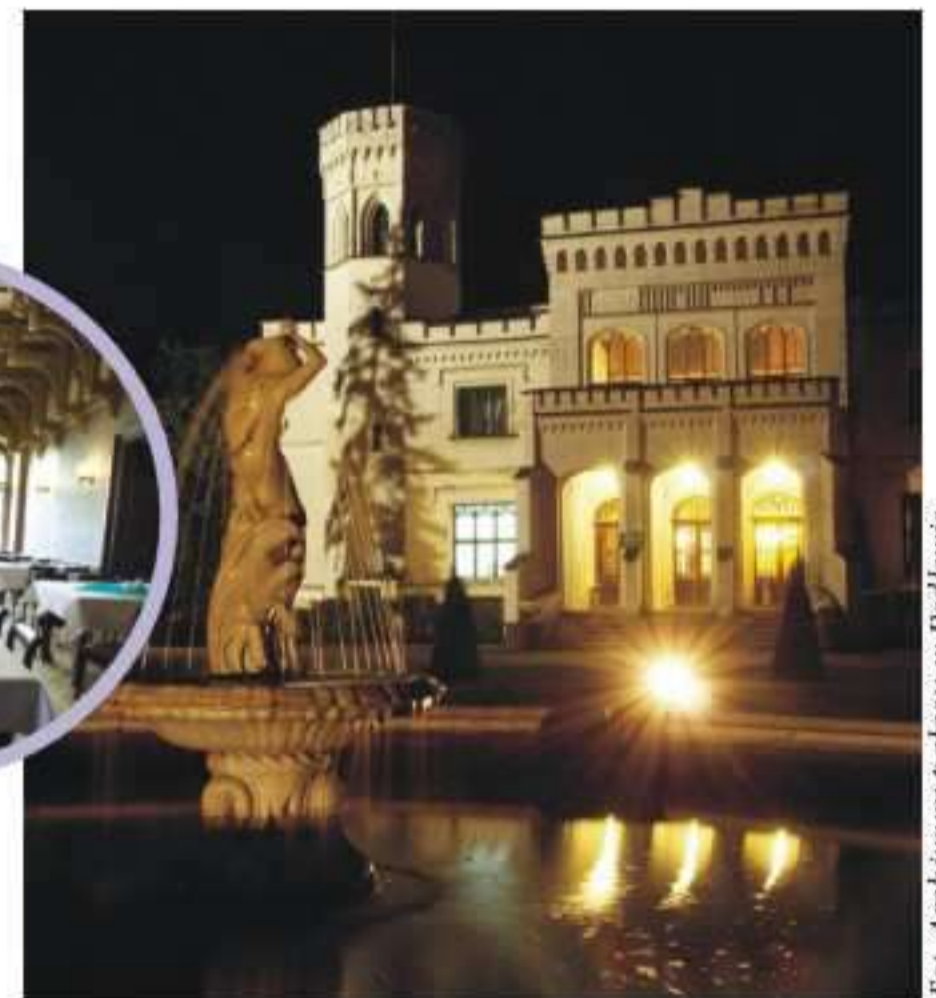
Pałac w Bedlewie - restauracja i fasada
